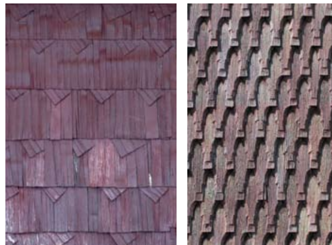
Placări din lemn pentru pereți exteriori, sisteme tradiționale
