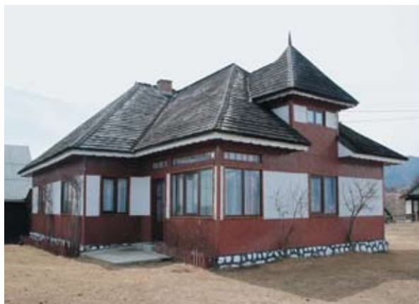
Acoperiș tradițional cu învelitoare din șită, satul Măgura
