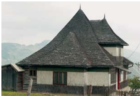
Acoperiș tradițional cu învelitoare din șită, satul Peștera
